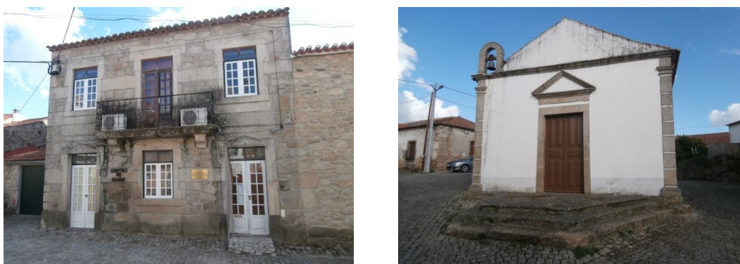
Figura 21. Centro de Saúde e Capela de São Sebastião de Medelim Fonte: SPI, 2016
